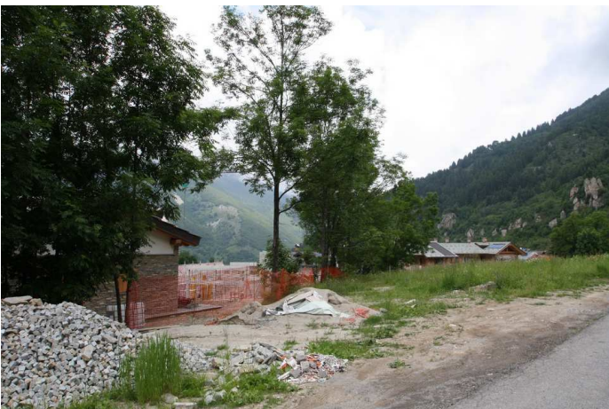
Sito dove sarà realizzata la torretta contatori gas
